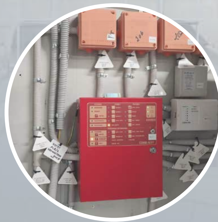
Система оповещения и управления эвакуацией
