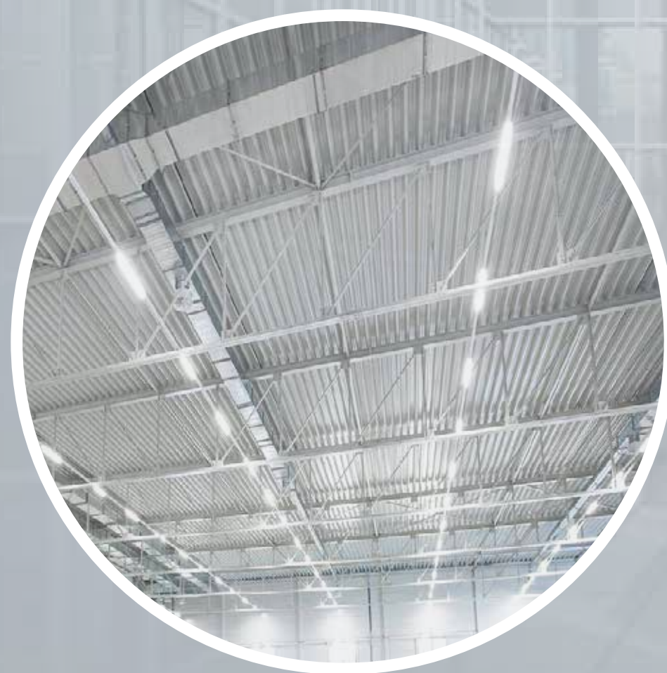
▲ Внутренние и наружные системы освещения
